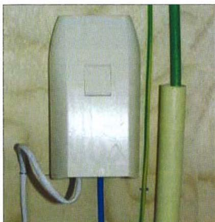
Fig. 8 - Terminação na residência
