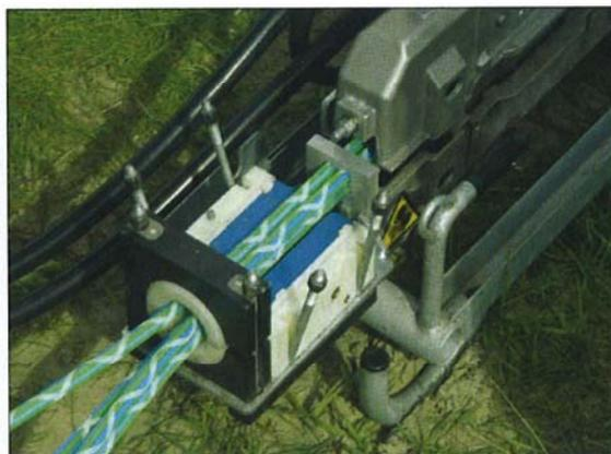
Fig. 2 - Injeção de quatro subfeixes, cada um com seis microdutos de 4 mm em torno do elemento de sustentação
